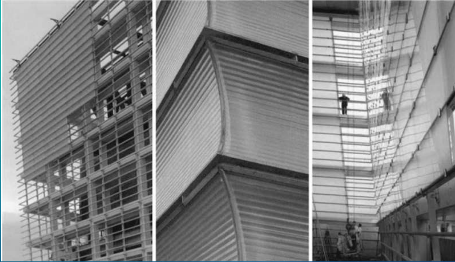
Kursaal San Sebastian ift ıdarlı cephe
