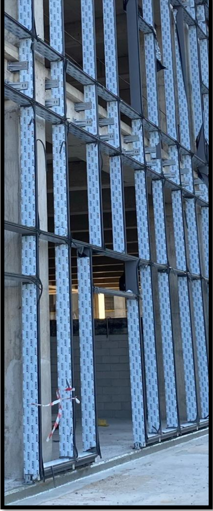
Giydirme cephe profil montajı
